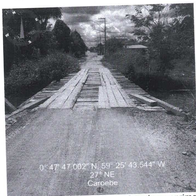
Foto 09: Ponte de madeira na vicinal 016 com 25 m de comprimento, com altura de 3,5 m, com 5,8 km de distância até o entrocamento da vicinal 016 (CAB-369) com a BR-210, observa-se o desgaste nas peças, devido ao recalque sofrido a ponte encontr-se em risco de colápsio.
