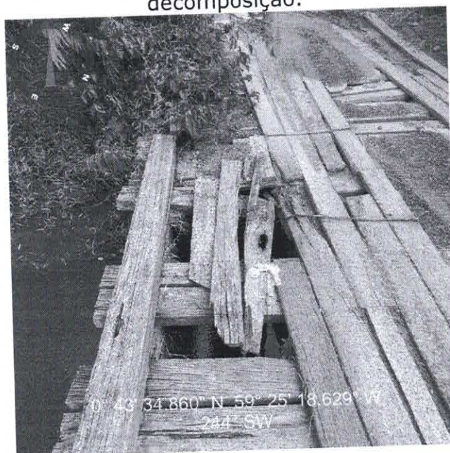
Foto 03: Ponte de madeira na vicinal 016 com 15 m de comprimento, com altura de 2,5 m, com 8 km de distância até o entrocamento da vicinal 016 (CAB-369) com a BR-210, guarda rodas solto e em
