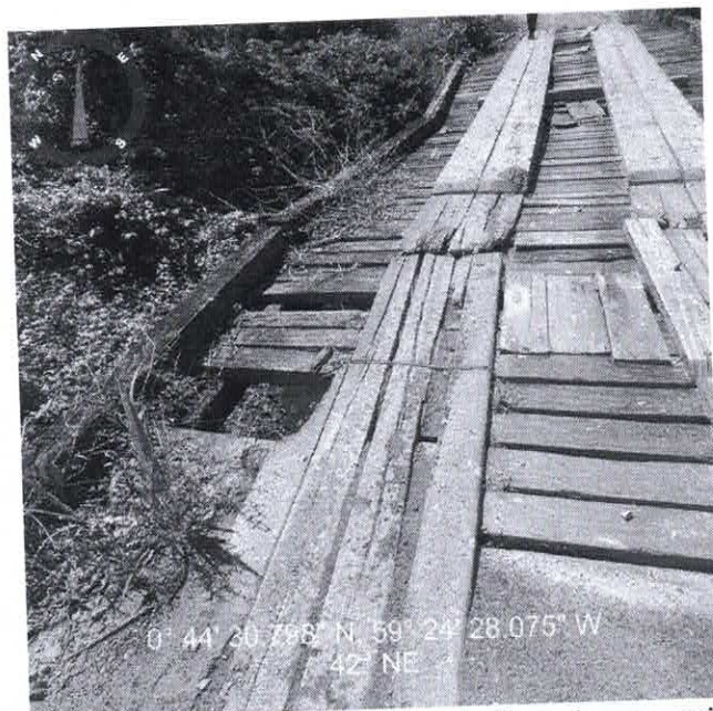
Foto 09: Ponte de madeira na vicinal 016 com 25 m de comprimento, com altura de 3,5 m, com 5,8 km de distância até o entrocamento da vicinal 016 (CAB-369) com a BR-210, observa-se o desgaste nas peças, devido ao recalque sofrido a ponte encontr-se em risco de colápsio.
